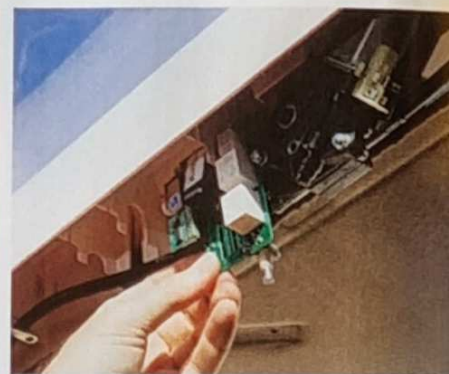
☑ Nun kann auch die Steuereinheit in den Dachfensterrahmen gesteckt werden.
