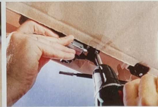
11 Motor und Getriebe werden im Fensterrahmen verschraubt. Dafür nutzt man die Löcher einer der ...
