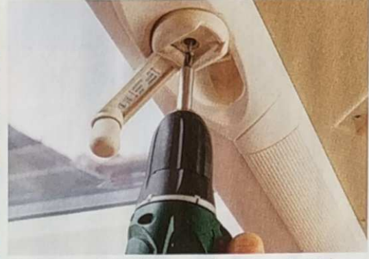
3 Als Erstes wird dafür die Handkurbel von der Welle des Kurbeltriebs abgeschraubt und abgenommen.
