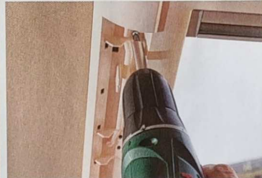
5 Sind die Blenden entfernt, kann man die Befestigungsschrauben ringsum alle herausdrehen.
