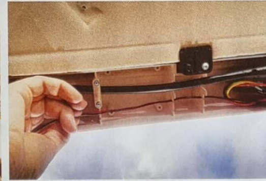
8 Zur Stromversorgung wird der mitgelieferte Kabelstrang angeschlossen und im Rahmen verlegt.
