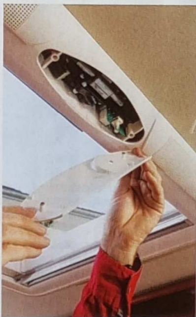
☑ Das neue Verkleidungsteil hält magnetisch am Dachfensterrahmen.
