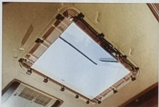
☑ Dann ist die gesamte Elektrik und Mechanik des neuen Dachfensterantriebs installiert und ...
